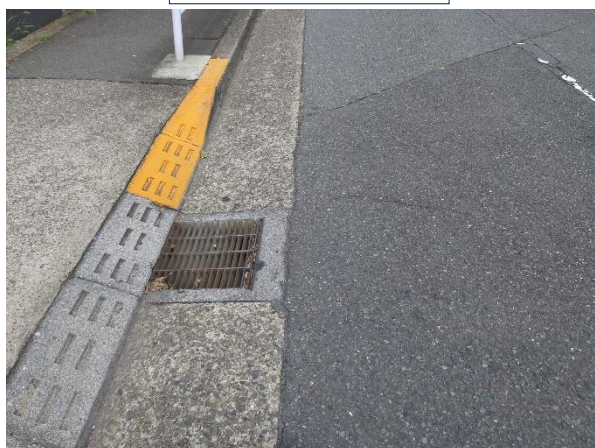
車道脇の傾斜している側溝 排水溝
