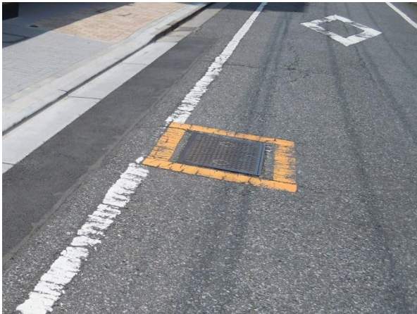
マンホールなどの蓋
