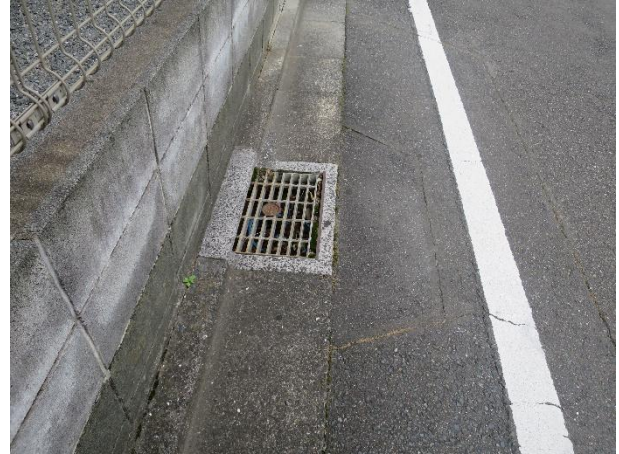
写真 27 側溝上に設置された排水溝
