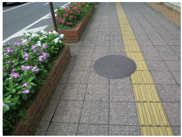
写真 26 歩道に設置された点字ブロックとマンホールの蓋
