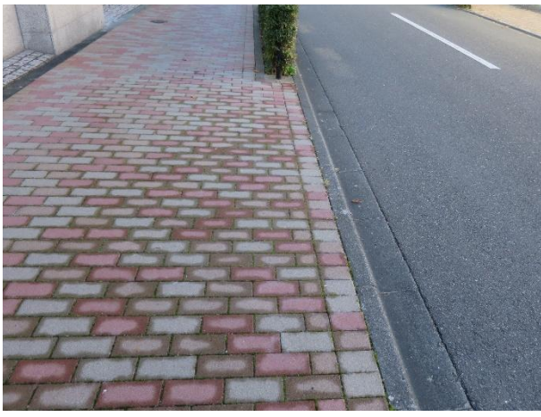
写真 25 コンクリートのブロックを敷き詰めた歩道
