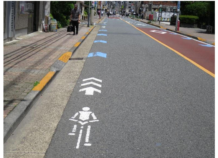
写真1 車道左側端路面に矢羽根の標示がある 車道混在
