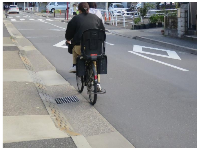
写真 8 側溝と車道の境界部通行時に転倒の危険がある側溝の施設
